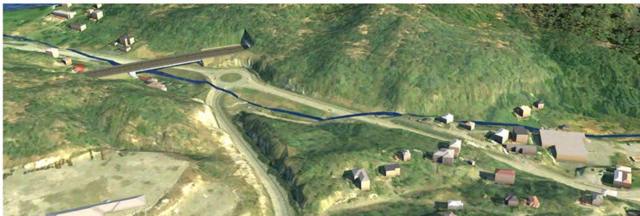
Figur 6-24 Ny E39 kryssar nedre Isdal på bru, eksisterande fylkesveg 57 går under brua. Illustrasjon: InfraWorksmodell.
