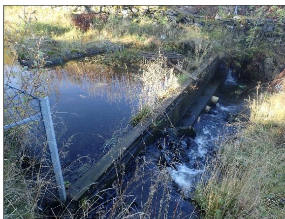
Figur 10. Øverst: Den største fangdammen i Mjåtveit rensepark (t.v.), bekken renner i kulvert under Mjåtveitstøvegen. Nederst: Fangdammen ved Rosslandsvegen.
